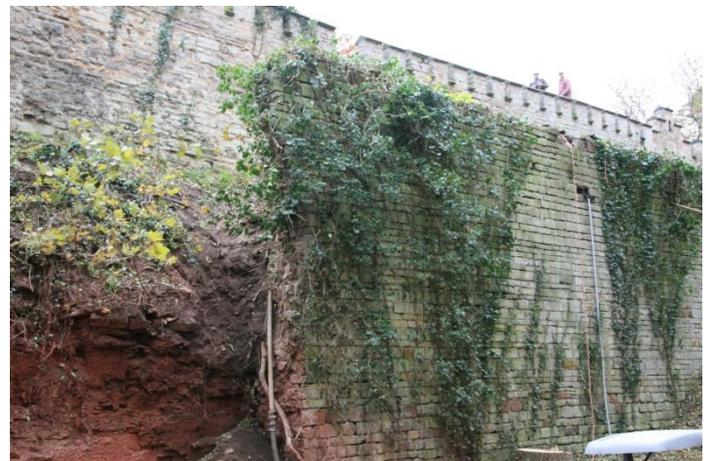
**Im Ringgraben werden fehlende Mauern bzw. eingestürzte Mauer wieder aufgebaut. In den Mauern werden im oberen Drittel Hohlräume für Fledermäuse mit Spaltzugängen eingebaut.**
