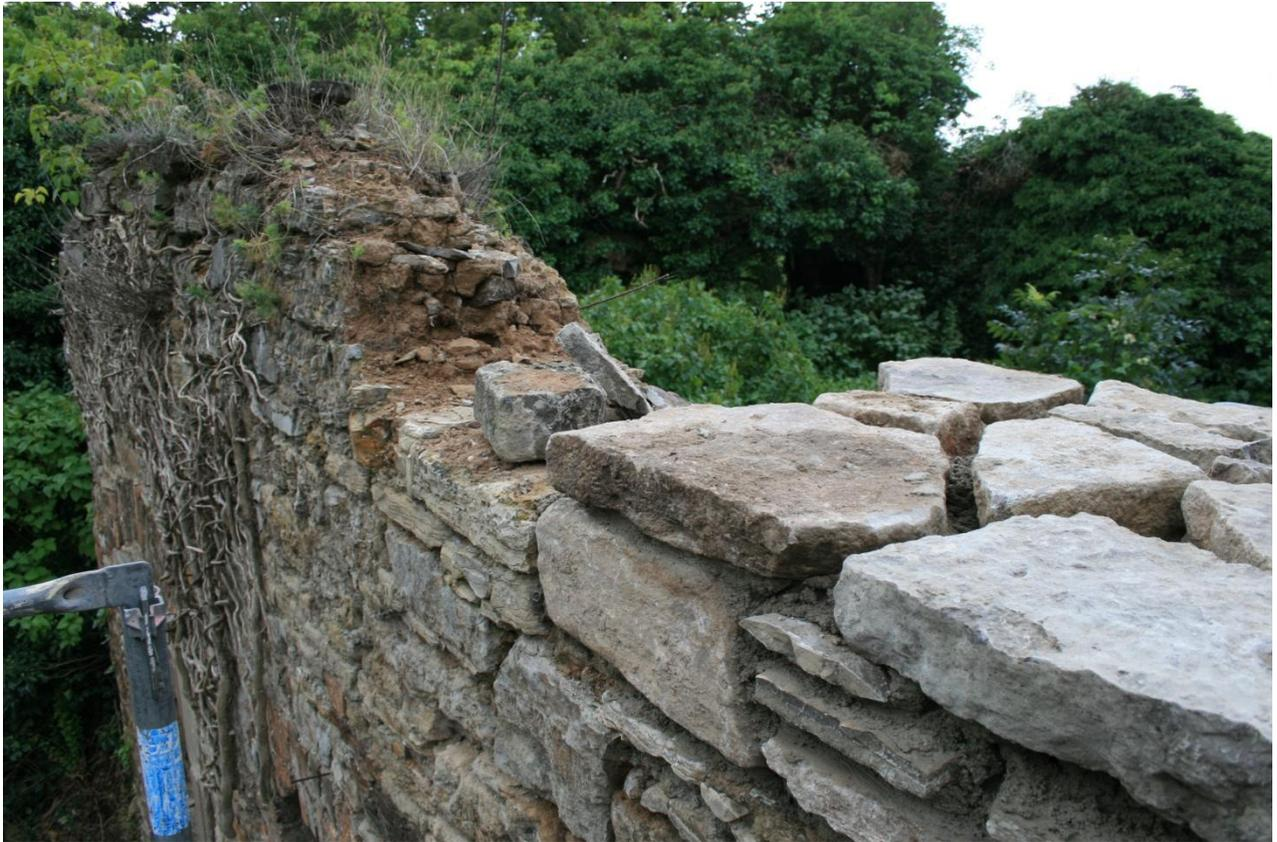
**Mauerkronen werden mit Platten abgedeckt. Unter den Platten werden Fledermausquartiere integriert. Im Bild links: unsanierte Mauer stößt auf sanierte Mauer.**
